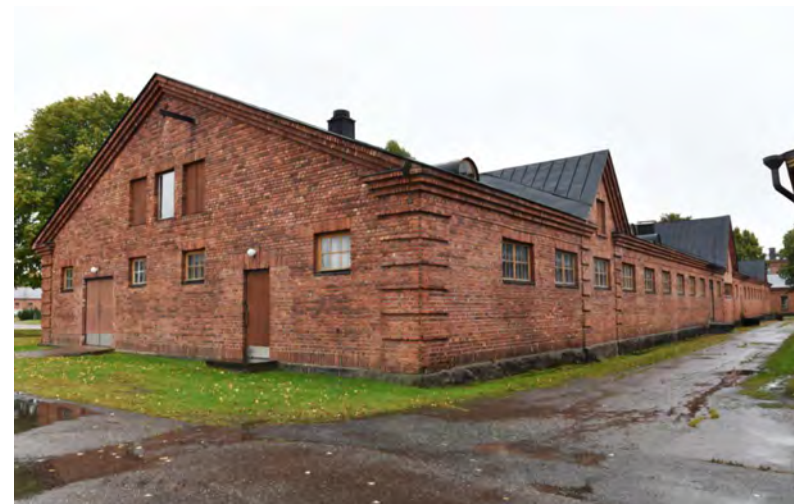
Kuva: Pitkän tiilirakennuksen räystäslinjassa on profiilimuuraus, nurkat on korostettu harkotuksella ja katolla on lunetti-ikkunoita. Pitkän kattolinjan katkaisevat jyrkkäharjaiset poikkipäädtyt, joista keskimmäisen kohdalla, molemmilla pitkillä sivuilla, on harkotusten reunustama sisäänkäynti.
