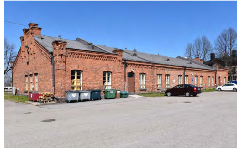
Kuva: Rakennuksen päädyissä on goottilaishenkiset sakaramuurit ja räystään alla kulkee hammaslista. Rakennuksen sisäänkäynnit on muutettu kadun puoleiselta sivulta pysäköintialueena olevan päävartiokentän puoleiselle sivulle, entisiin ikkunaukkoihin.
