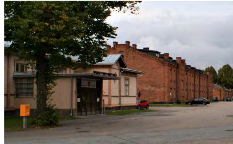
Kuva: Puurakennus ja sitä vastapäätä olevat kolme sotilaskasarmia kuuluvat samaan suomalaiskaudella toteutettuun kompositioon. Puurakennus näkyy myös keskusaukion suuntaan. Rakennuksen nykyinen pääsisäänkäynti poikkeaa rakennuksen vanhasta tyylistä.
