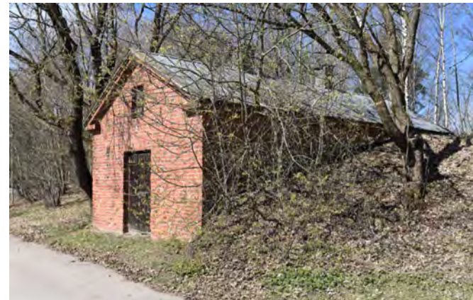
Kuva: Kellarirakennuksesta on uusittu vesikate ja ulko-ovi.
