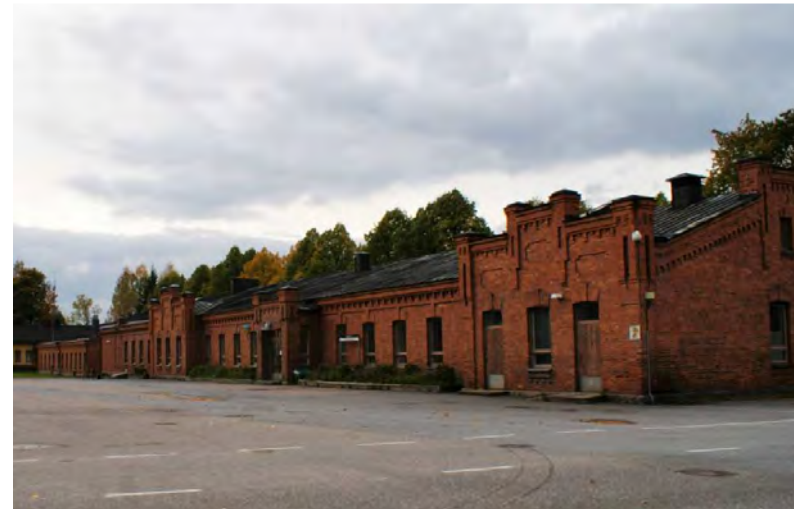
Kuva: Pitkillä sivuilla on kaksi seinälinjasta ulkonevaa risaliittia, jotka osoittavat keittiöiden paikat. Syvärunkoisen rakennuksen päädyissä ja pääsisäänkäynnin portaalissa on goottilaishenkiset sakaramuurit (ainoat peililaiheisella koristemuurauksella varustetut) ja räystäään alla kulkee hammaslista.
