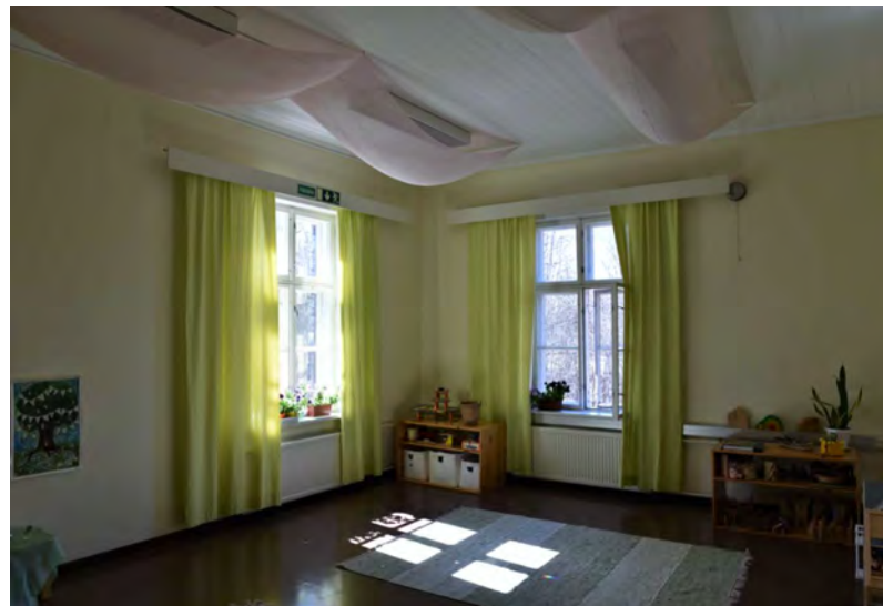
Kuva: Yläkerran kulmahuone: vanhat sisään-ulosaukeavat ikkunat, maalattu paneelikatto, laattalattia ja paneelipatterit.
