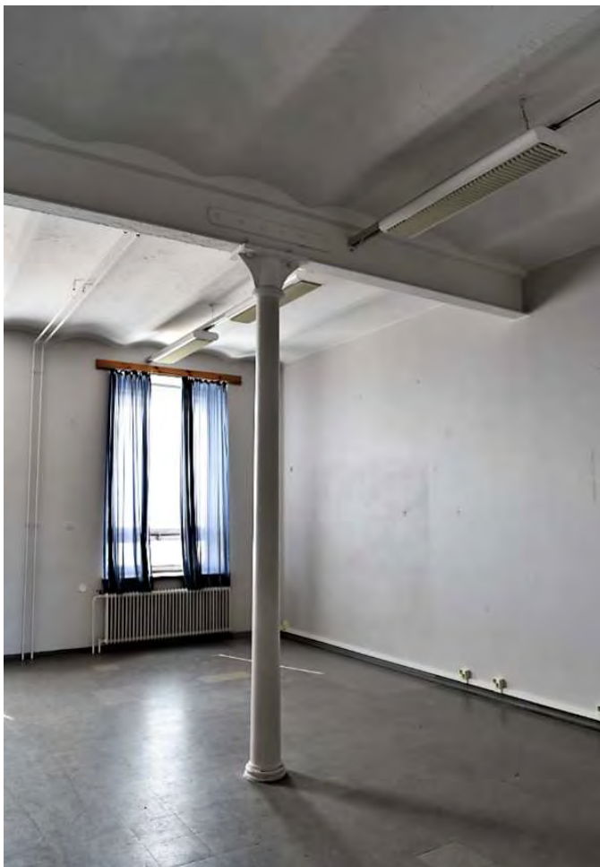
Kuva: Entinen majoitustupa, jossa näkyvissä katon kappaholvit. Rautapylväs ja vaakapalkki.
