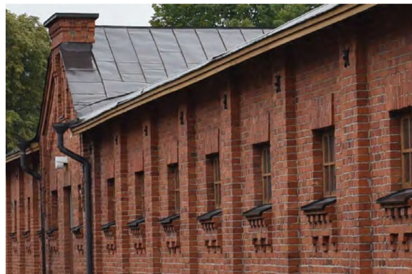
Kuva: Venäläiskauden tallirakennusten julkisivuja leimaa struktuuri, joka syntyy kapeista liseeneistä ja pienistä vaakaikkunoista, joiden alaosassa on koristeellinen muuraus. Ristipäädyn harjalla on sakara. Räystäään alla on puiset profiloidut katonkannattajat.
