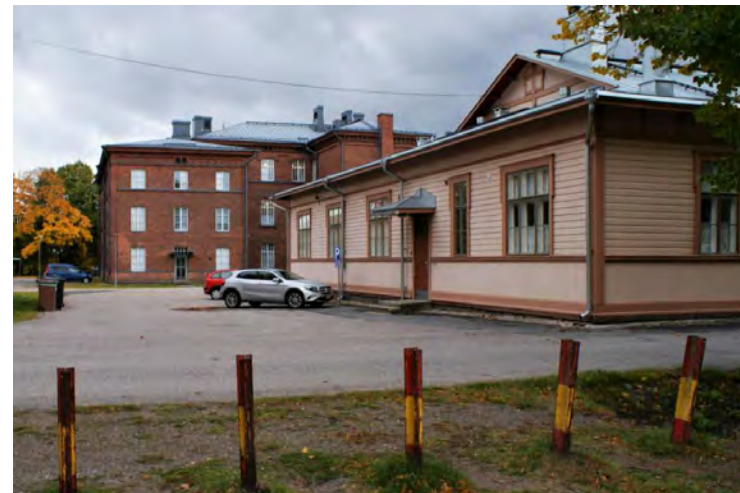
Kuva: Rakennuksen itäpäädyssä ikkunoiden määrä on aikaisempaa pienempi ja ikkunat alkuperäisiä suuremmat. Kahdesta sisäänkäynnistä on jäljellä toinen.
