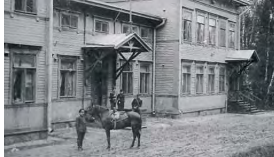
Kuva: Vanhassa kuvassa paraatisisäänkäynti ja pohjoissiiven sivuovi ovat alkuperäisellä paikallaan. Nykyään keskiosan oikeanpuoleisimman ikkunan kohdalla on sivuovi ja siiven oven paikalla on ikkuna. Siivestä on myös laudoitettu umpeen oven vasemmalla puolella ollut ikkuna-akseli. Rakennuksen katto on ollut alusta alkaen peltinen. / Kuva julkaisusta: Immonen 1992, Varuskuntahistoria.
