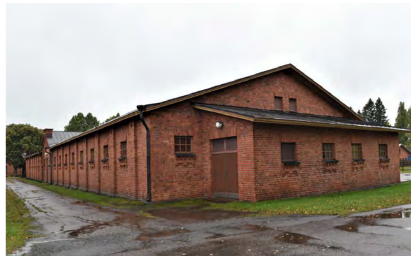
Kuva: Tallirakennus sijaitsee keskusaukion länsipuolella sijaitsevan tiilirakennusryhmän keskellä, pääty Mannerheiminkadun suuntaan.
