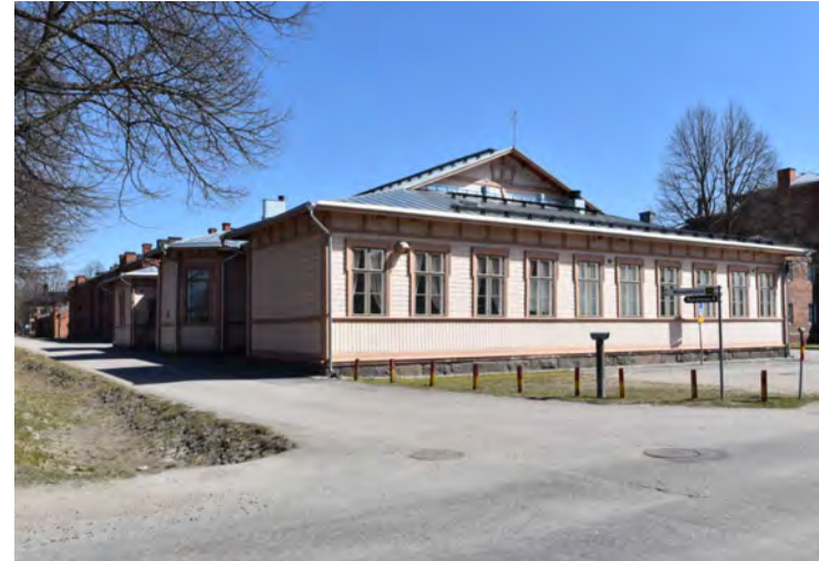
Kuva: Rakennuksen länsisiivestä on poistettu kaksi sisäänkäyntiä ja ikkunat yhtenäistetty kooltaan, mutta muulta osin tyyli on entisenlainen. Rakennuksen erikoisuutena on lohkokivijalan yläosassa näkyvä punatiilikkerros.
