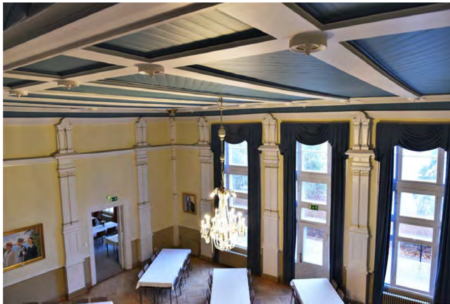
Kuva: Juhlasali on kuvattu soittokunnan lehteriltä. Viime sodissa vaurioita kärsineen ja kunnoltaan rapistuneen juhlasalin peruskorjaus valmistui 1956. Tämän jälkeen on tehty lähinnä ylläpitokorjauksia.
